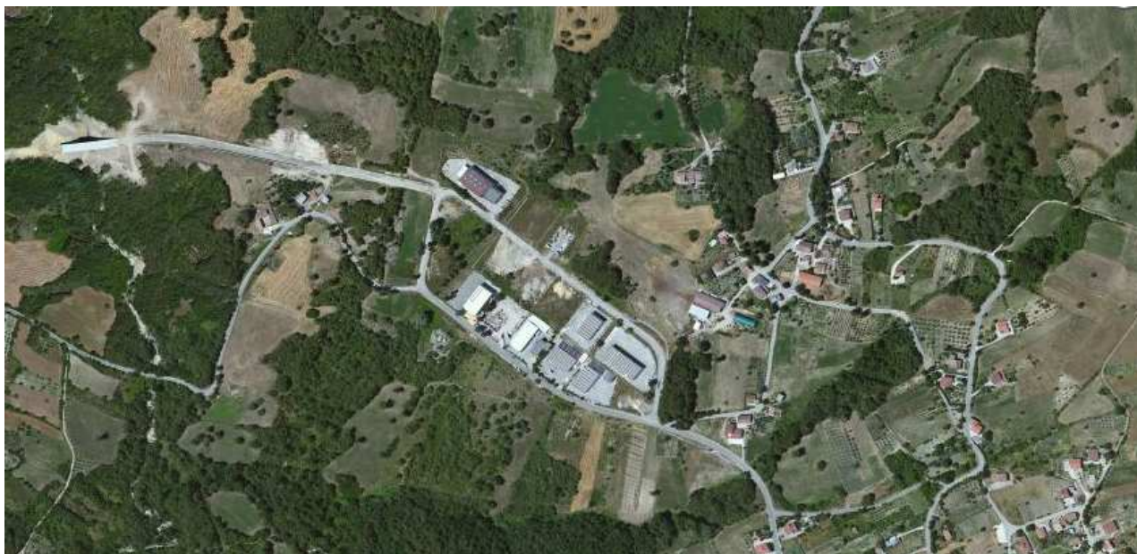
Fig. 1 - vista aerea della zona industriale di Molinara: la prima costruzione in alto è il capannone in esame
